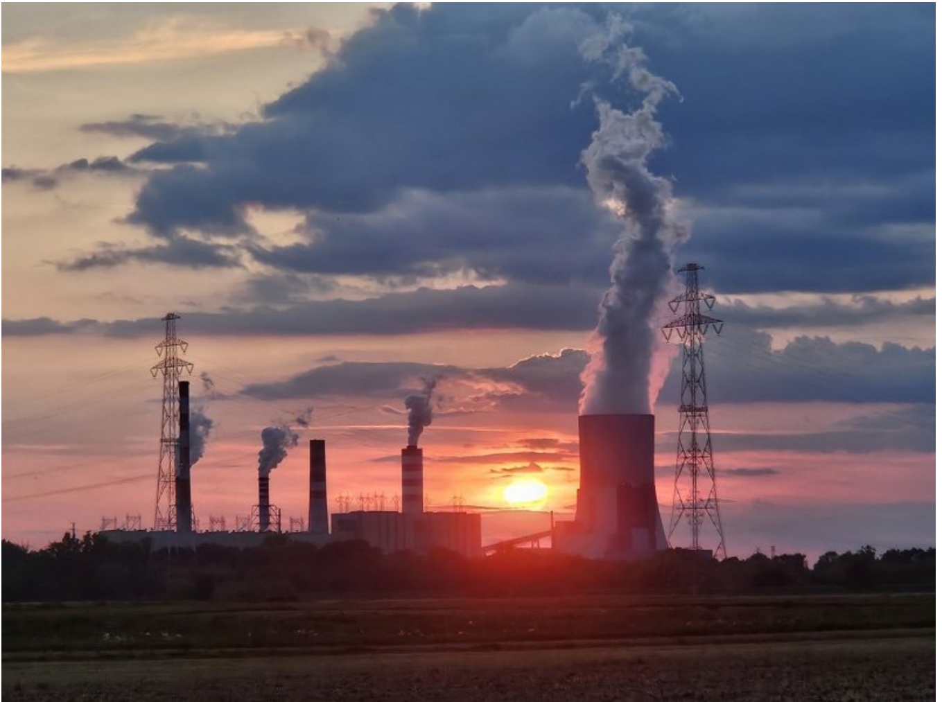
Wyróżnienie -Tomasz Pakuła-ENEA WYTWARZANIE
