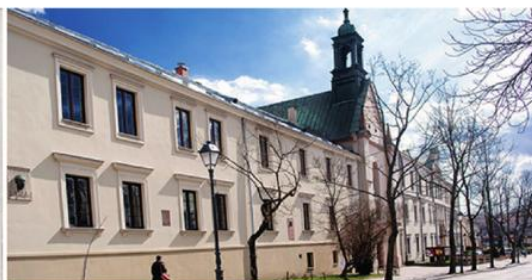
Rys. 3. Budynek gimnazjum kieleckiego dawniej i dziś
