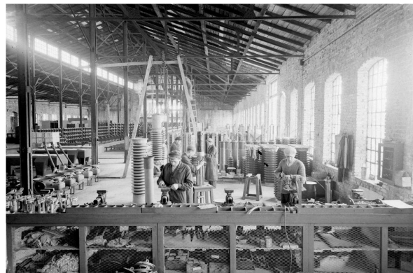
Zdj. 10. Hala produkcyjna w Międzylesiu, montaż aparatury na napięcie 150 kV
