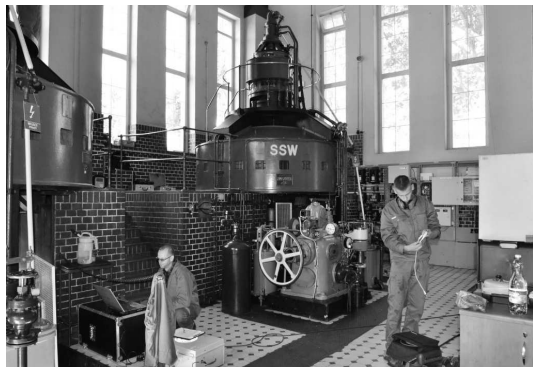
Rys. 5. Pomiary hydrogeneratorów w elektrowni wodnej Włodzice na Dolnym Śląsku. (fot. materiały Energotest-Diagnostyka)
