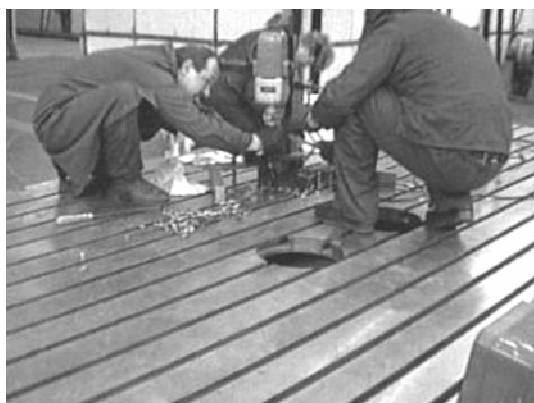
Rys. 3. Prace związane z modernizacją stanowiska (fot. materiały Energotest-Diagnostyka)
