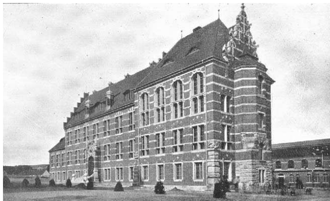
Rys. 5. Budynek Instytutu Elektrotechnicznego, 1904 (zbiory Sekcji Historycznej PG)
