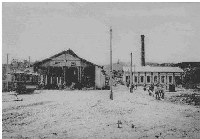
Rys. 3. Wozownia tramwajów. Widok z ul. Wóleckiej. W głębi elektrownia, 1894r.
