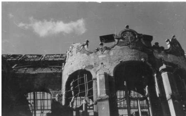
Rys. 14. Fragment zniszczonego gmachu głównego (zbiory Sekcji Historycznej PG)
