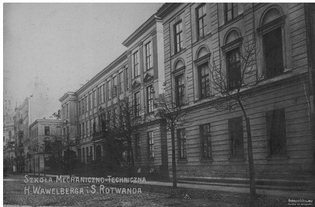
Rys. 3. Szkoła H. Wawelberga i S. Rotwanda [1]
