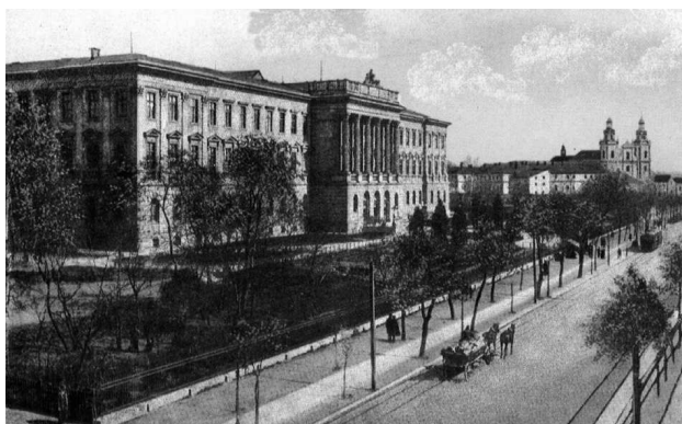
Rys 1 Budynek główny CK Szkoły Politechnicznej
