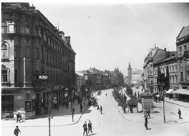
Rys. 7. Stacja transformatorowa na ul. Akademickiej
