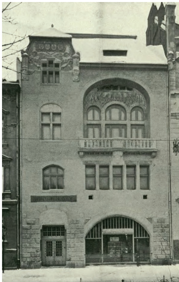
Rys. 11. Siedziba Krakowskiego Towarzystwa Technicznego otwarta w 1906 r. (źródło: Czasopismo Techniczne 1906, nr 3)
