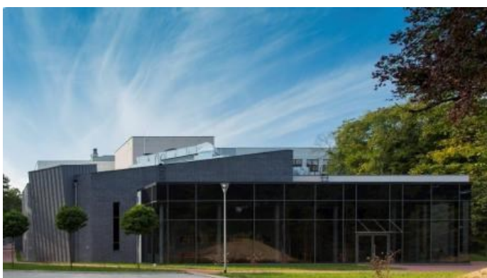
Fot. 6—nowy budynek Wydziału Elektrycznego ZUT
