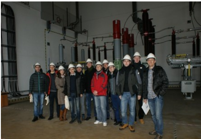
Fot. 4 - w rozdzielni 110 kV stacji RPZ – 3 Białystok
