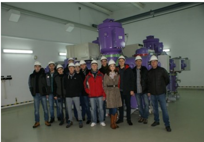
Fot. 5 - w rozdzielni 110 kV stacji RPZ – 11 Białystok
