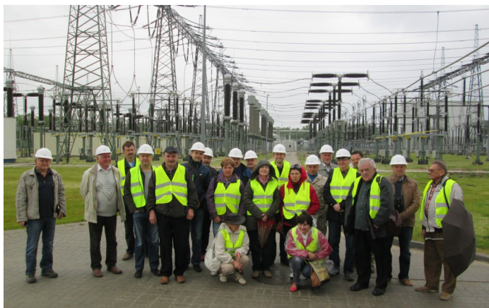
Fot. 5- uczestnicy wycieczki na terenie stacji elektroenergetycznej w Wierzbicinie
