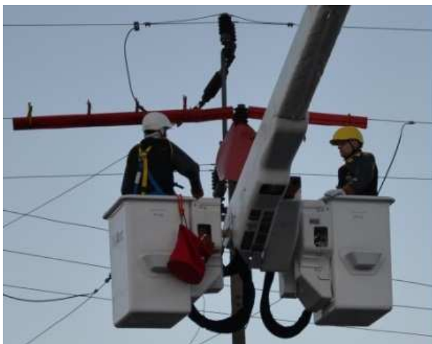
Fot. 1. Pokaz poligonowych prac z podnośnika do prac pod napięciem.
