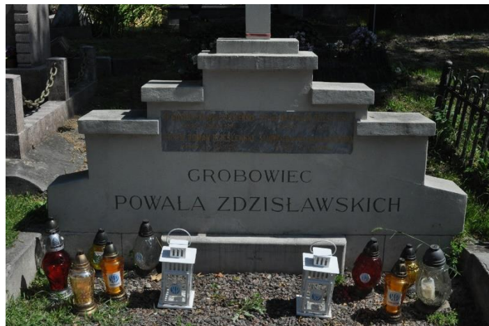
Fot. 5. Grobowiec po poprawkach konserwacyjnych.
